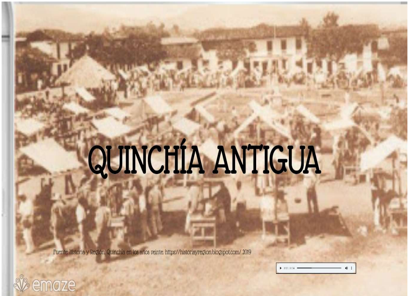
Ilustración 12. Ubicación de la fotografía dentro de la galería
